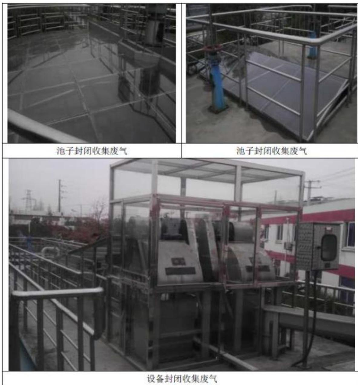
图 5.2-3 其他同类型污水处理厂的废气封闭收集图
