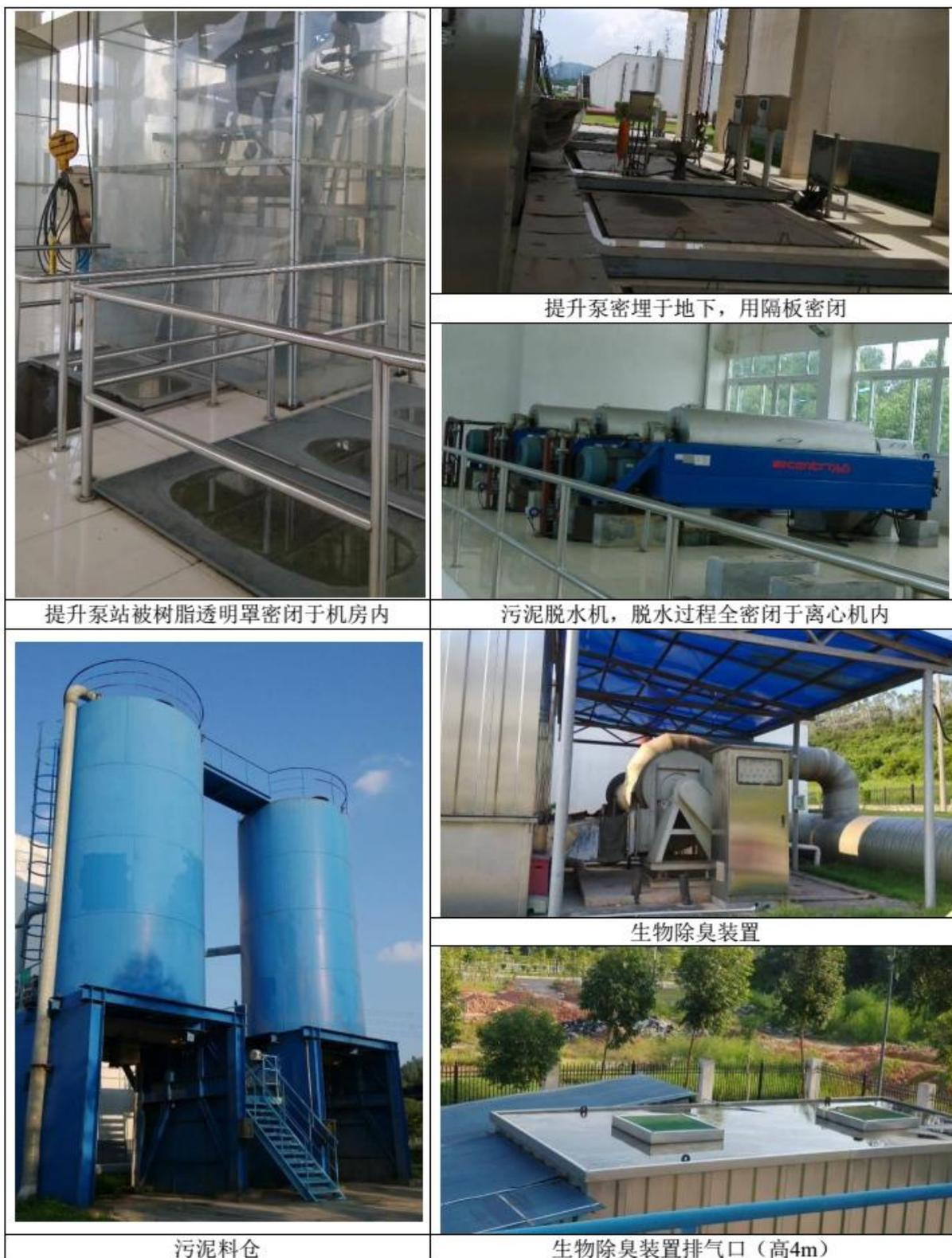
图 5.2-2 松岗水质净化厂一期项目的废气封闭收集图
